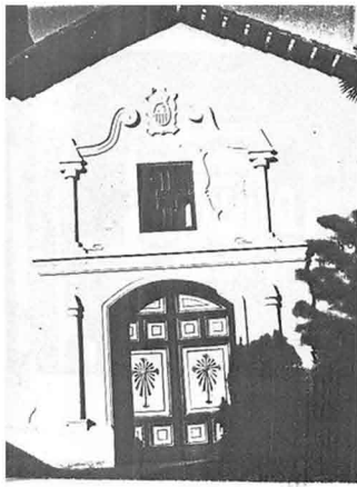
FACADA FOTOGRAFIA Nº 10.
